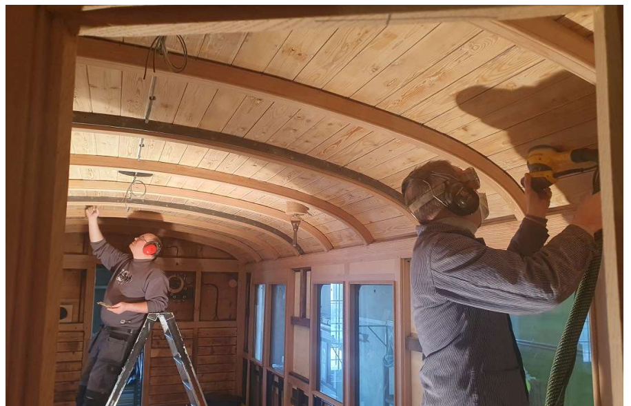
letzte Schleifarbeiten an der Decke im Raucherabteil
