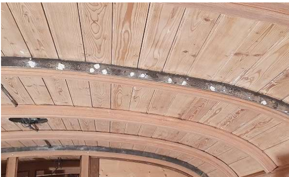
noch blanke Stahlbänder der Dachspriegel
