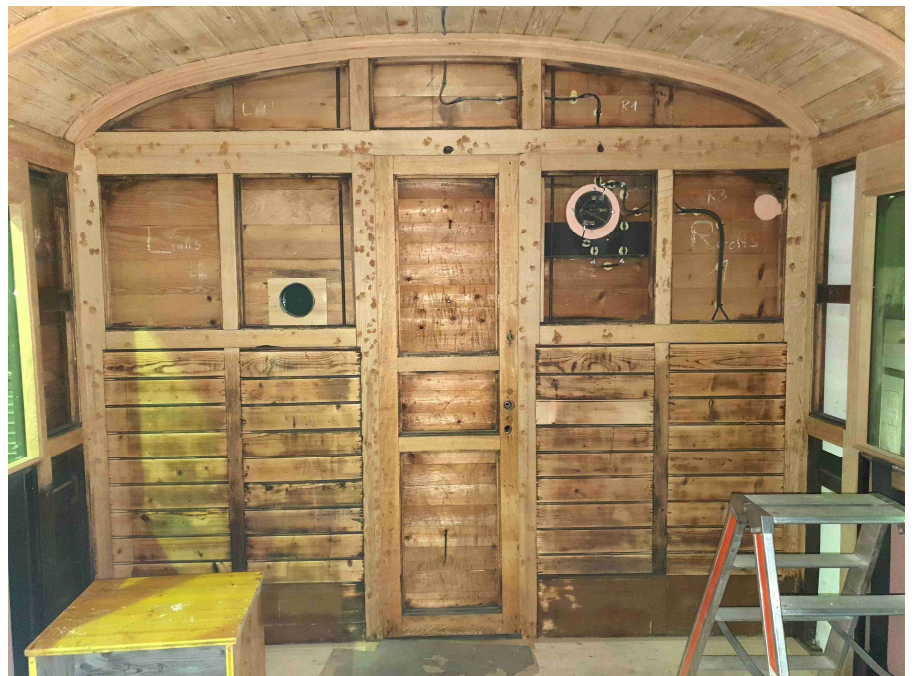
Noch viele Flecken: gespachtelte Stirnwand vor dem Schleifen
