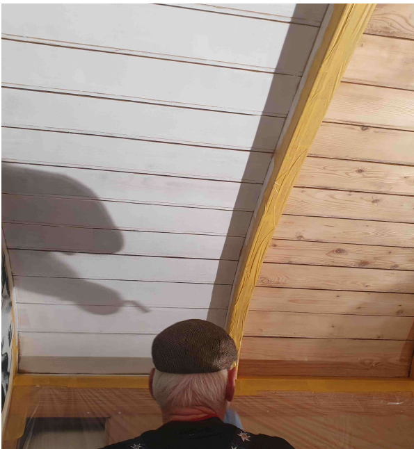
erster Anstrich der Decke mit Haftvorlack
